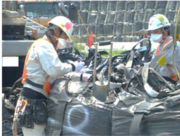
図 2.1.3-8 容器の表面線量率の測定状況
