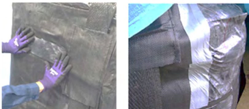
図 2.1.3-4 保管容器の補修
