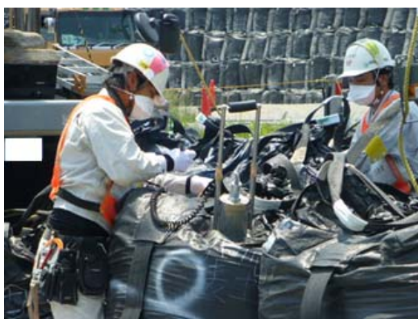
図 2.1.3-7 容器の表面線量率の測定状況
