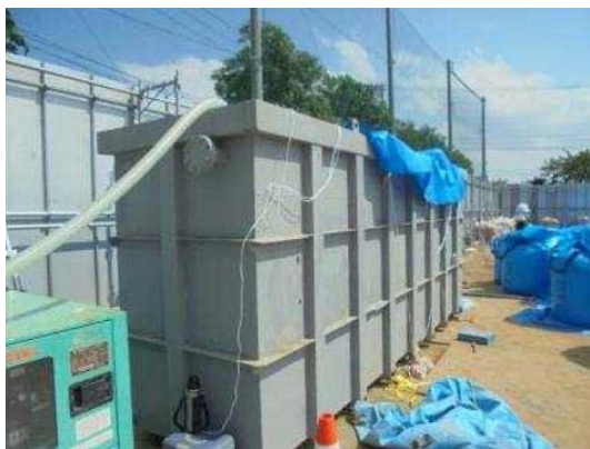
図 2.1.3-4 発生する濁水や浸出水等の回収と処理
