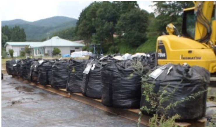
図 2.1.3-5 水切り架台の設置状況の例
