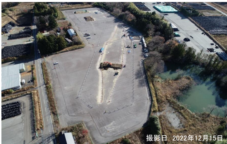
準備工事(盛土工(スロープ部))
