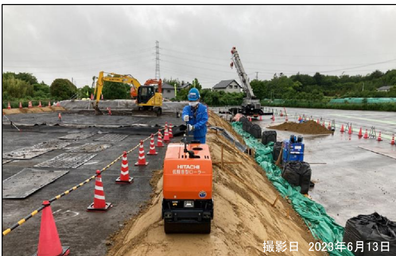
法面部の覆土作業状況
