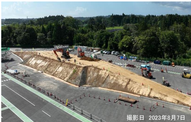
路床盛土工(覆土)
