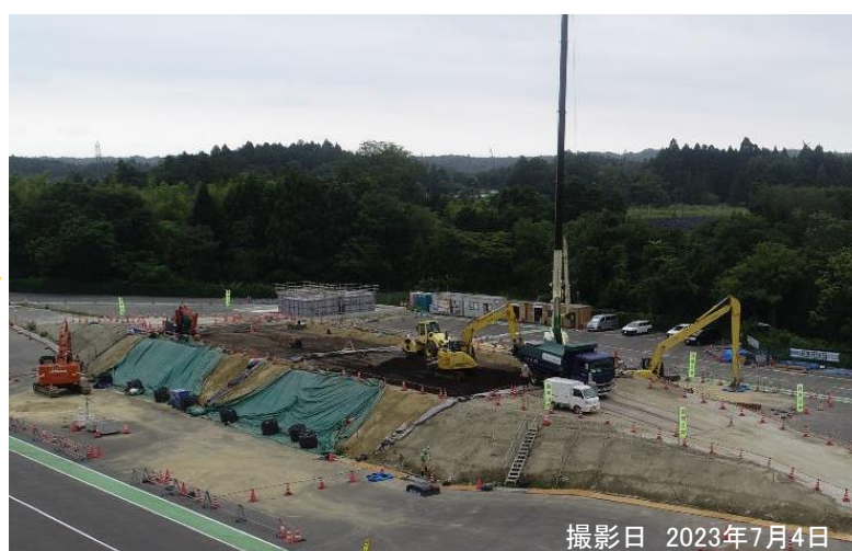
路体盛土工(路体11層目)
