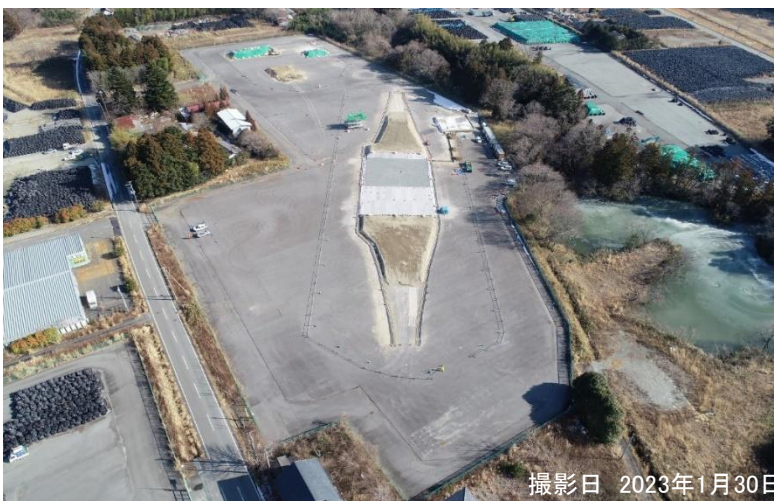
準備工事(盛土工(スロープ部))
