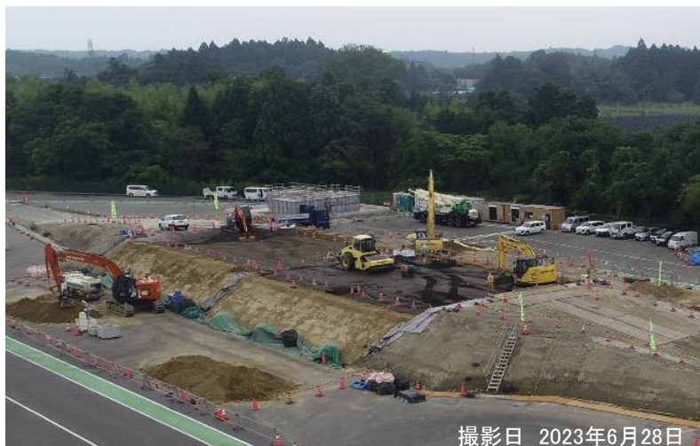
路体盛土工(路体9層目)
