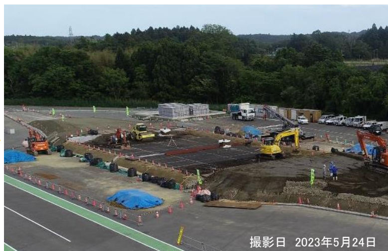
路体盛土工(2層目)
