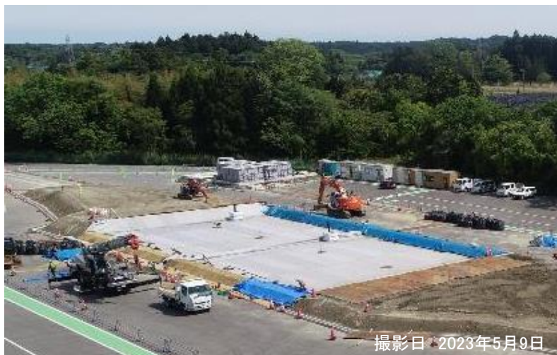
浸透水処理工(盛土底盤部)
