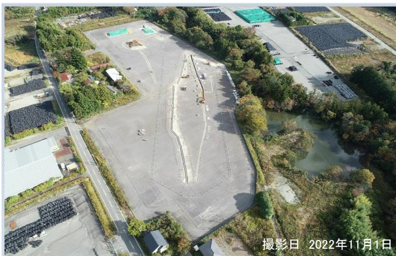
準備工事(排水工)
