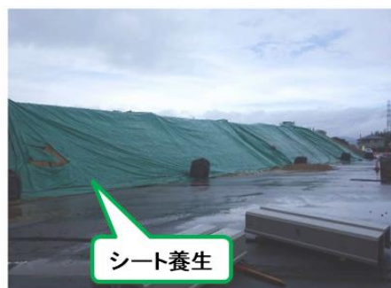
法面部シート養生設置状況
