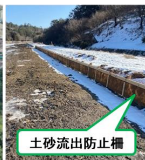
土砂流出防止柵設置状況
