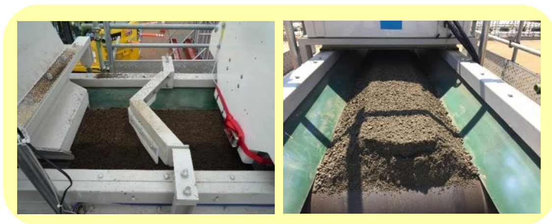
図 2-5 ベルトコンベヤによる放射能濃度測定装置 (南相馬市仮置場における試験盛土造成実証事業の例)
