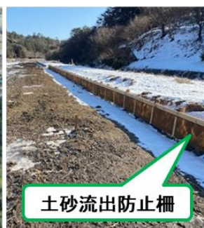
土砂流出防止柵設置状況
