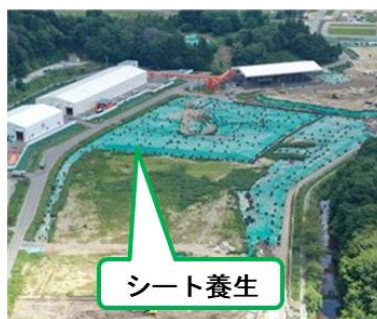
シート養生状況
