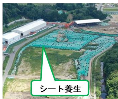
シート養生状況
