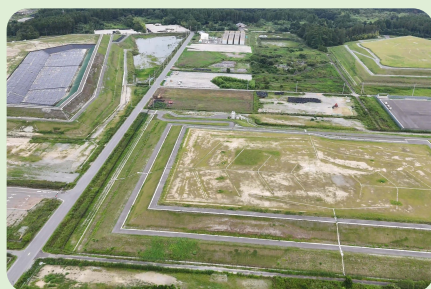
※中間貯蔵施設整備後
