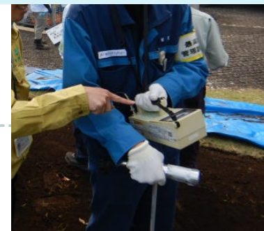
施工中のモニタリング（最高裁）
