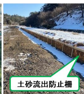
土砂流出防止柵設置状況
