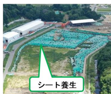
シート養生状況
