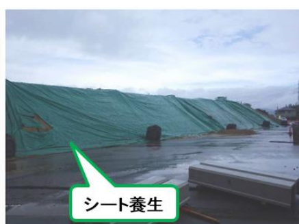
法面部シート養生設置状況
