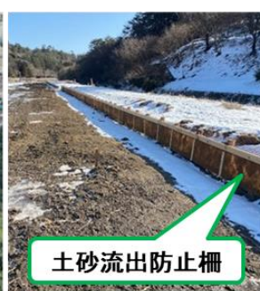
土砂流出防止柵設置状況
