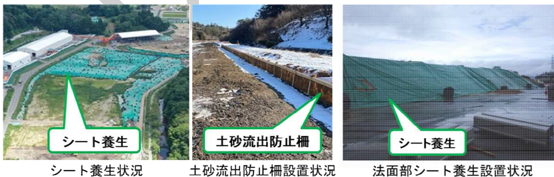
図 2-11 施工中の飛散・流出防止対策の実施例
