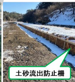
土砂流出防止柵設置状況
