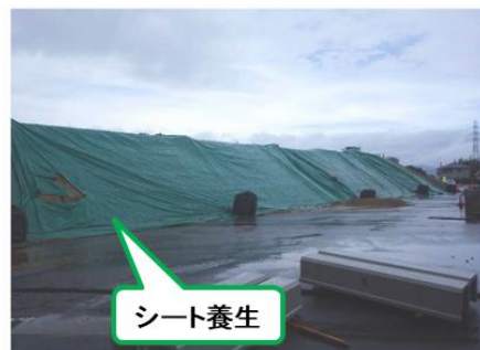
法面部シート養生設置状況
