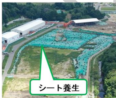
シート養生状況
