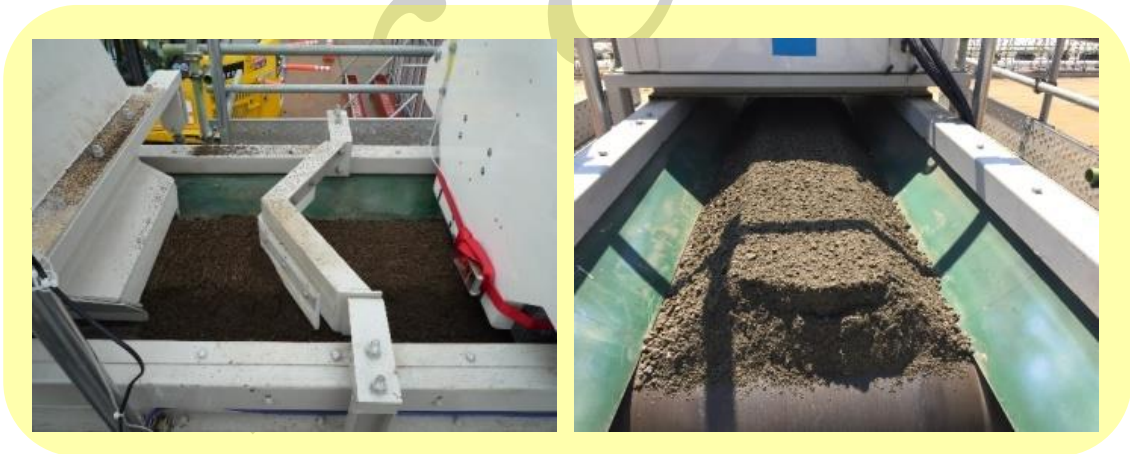
17 18 図 2-5 ベルトコンベヤによる放射能濃度測定装置 19 (南相馬市仮置場における試験盛土造成実証事業の例) 20
