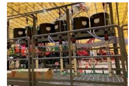
その3事業者：実証試験設備
