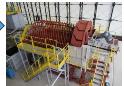
沈降分離により、砂と粘土・シルトを分別し、主に「砂」を回収する設備
