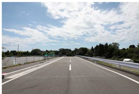
【①総重量約10t走行前】
