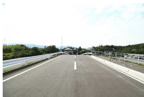
【①総重量約10t走行前】
