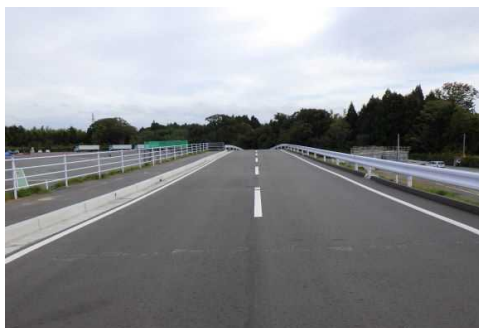
【③総重量約25t走行後】
