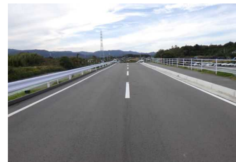
【③総重量約25t走行後】
