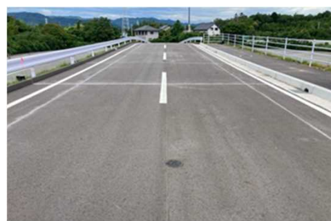
【②総重量約20t走行前】
