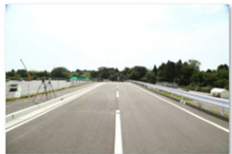
【②総重量約20t走行前】
