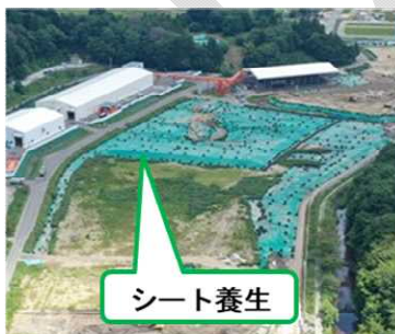
シート養生状況
