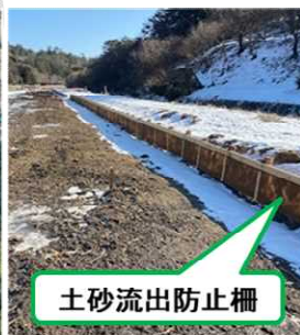
土砂流出防止柵設置状況
