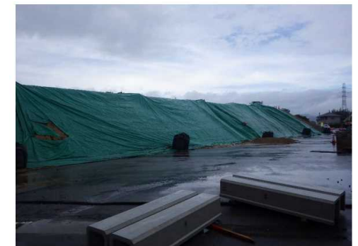
法面部シート養生設置状況
