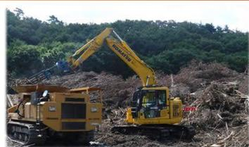
盛土による沈下等を抑えるために、腐植物を除去します。
