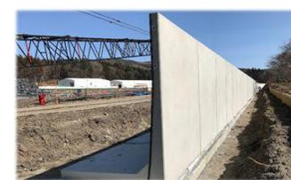
農地盛土のかさ上げに伴い、自然災害等で再生資材が流出しないように土留めの擁壁を設置します。
