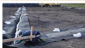
盛土の安定性を確保するために地下水・湧水を集水する排水管を設置します。
