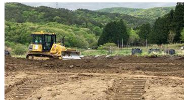
再生資材からの被ばく線量低減のため、盛土の上に50cm以上覆土します。覆土(山砂)は20mm以下のものを使用します。
