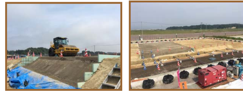
写真1-3 盛土実証試験状況
