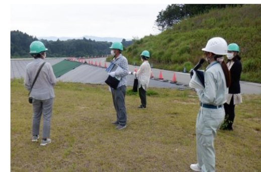
大熊工区 土壌貯蔵施設
