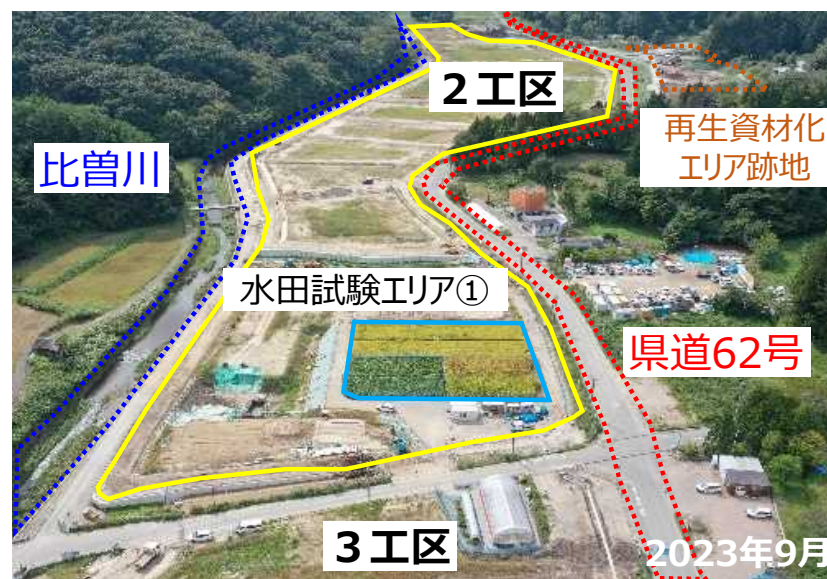
飯舘村長泥地区における農地造成実証事業 (環境再生事業)現場2工区、3工区農地盛土造成状況
