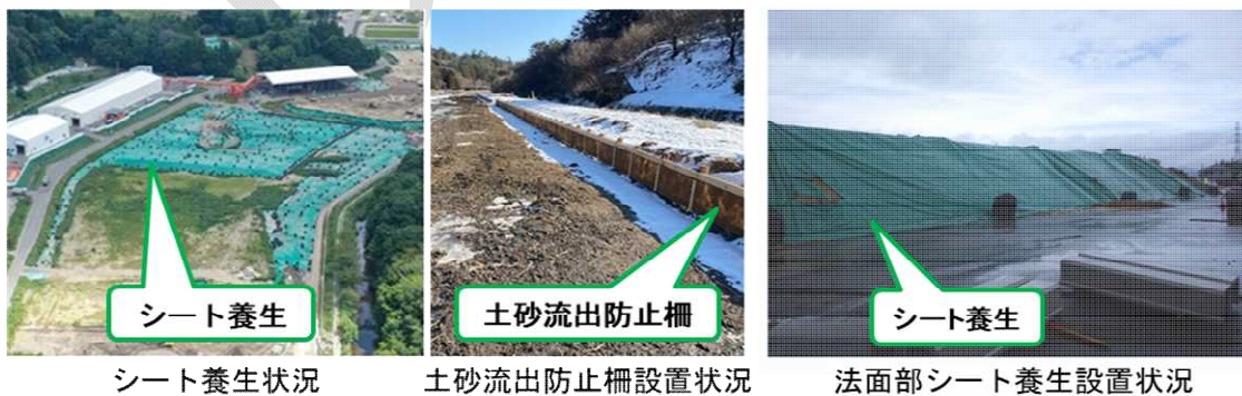
図 3-5 施工中の飛散・流出防止対策の実施例
