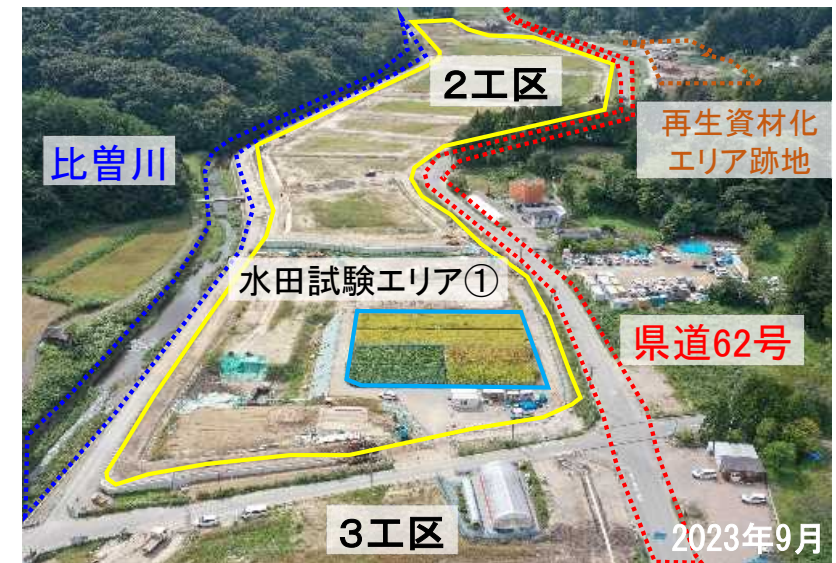
飯舘村長泥地区 2工区、3工区農地盛土造成状況
