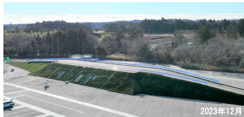
◇中間貯蔵施設内(大熊町)での道路盛土実証事業
