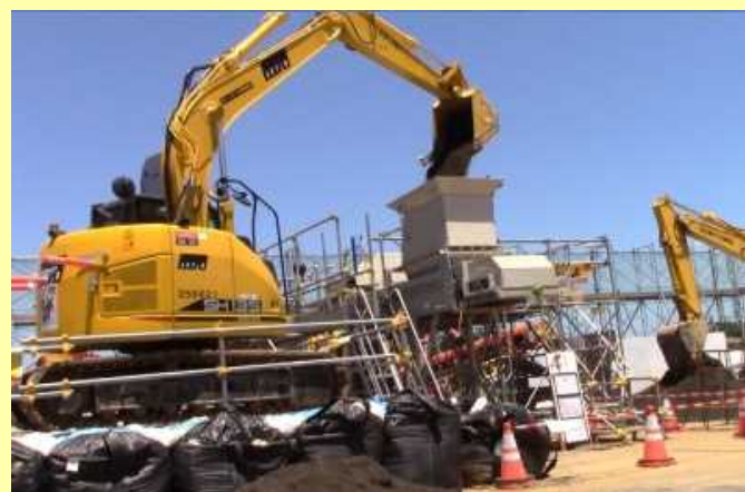
ホッパーへの除去土壌投入
