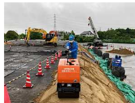
路体盛土覆土転圧状況
