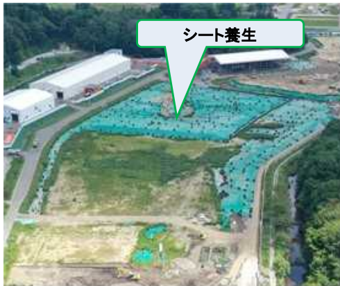
シート養生状況
