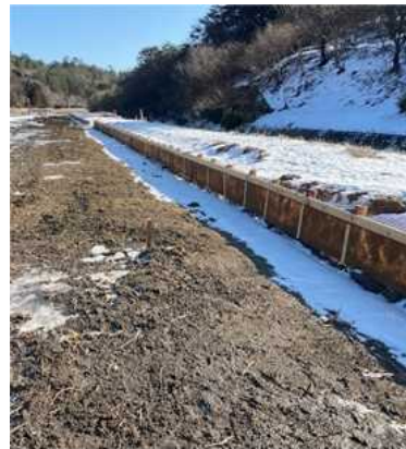
土砂流出防止柵設置状況
