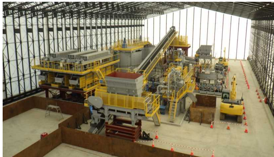
テント内全景 (11/29)
