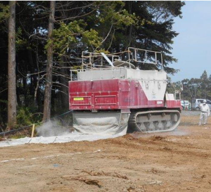
地盤改良工事 (7/18)
