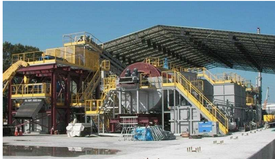
機器設置完了 テント設置、配管工事 (10/26)
