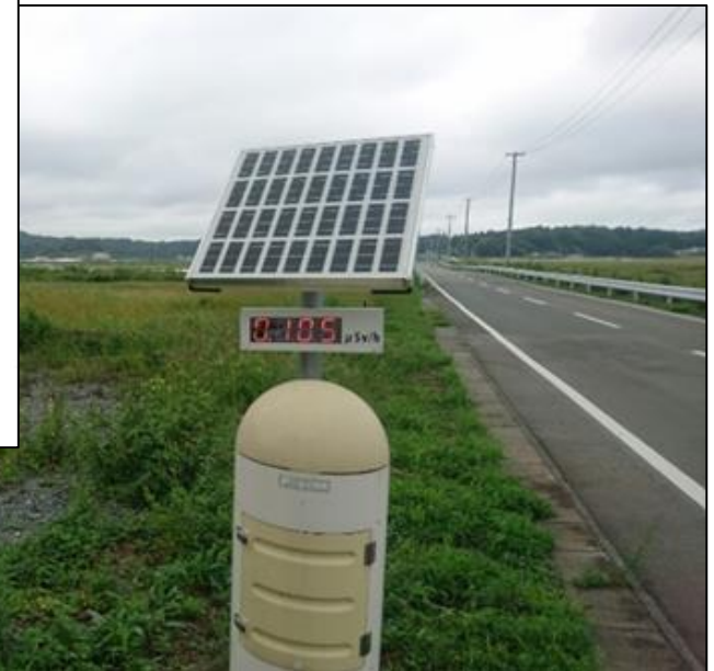
空間線量率等のモニタリング(モニタリングポストの例)
