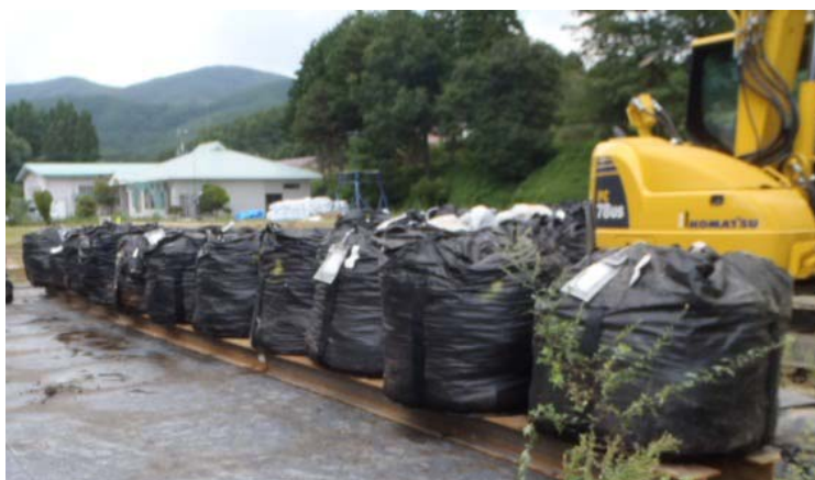
図 3-10 水切り架台の設置状況の例
