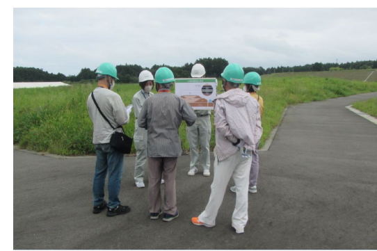
双葉工区 土壌貯蔵施設
