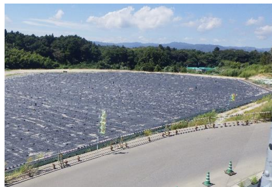
土壌貯蔵施設の状況
