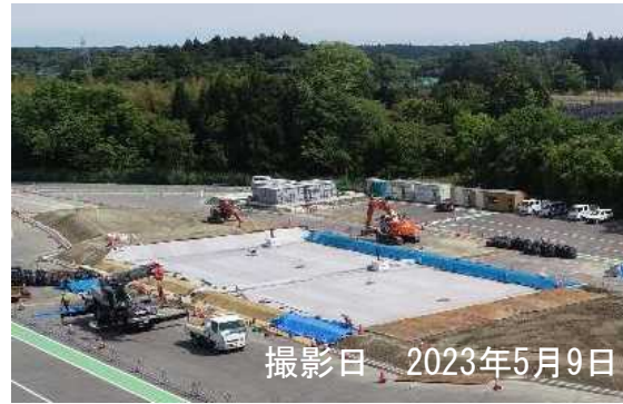
浸透水処理工（盛土底盤部）
