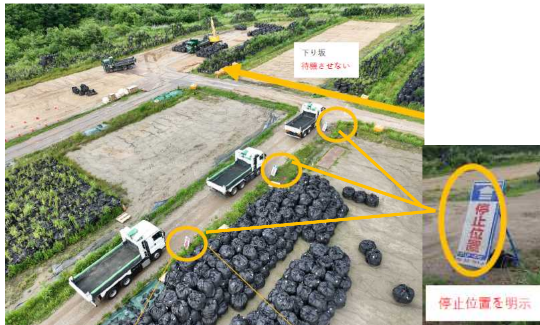
【現場の対策状況】
