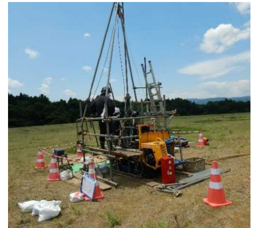
図1. ボーリング調査の様子(双葉②工区)
