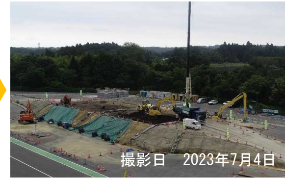
路体盛土工（路体11層目）
