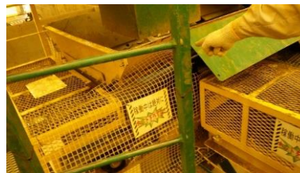
可動部へのネット敷設状況
