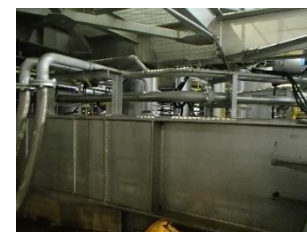
仮設灰処理施設(その1)復旧状況
