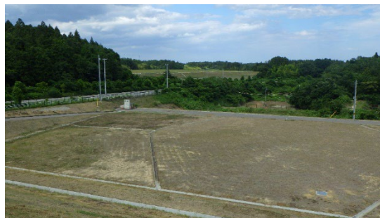
土壌貯蔵施設の状況
