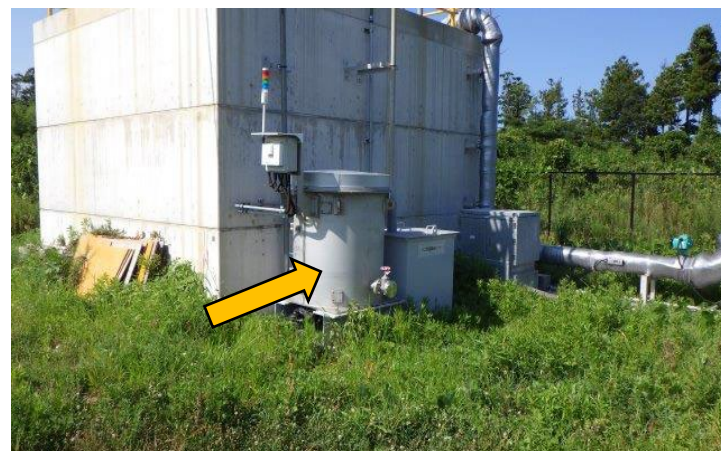
地下水（K2区画）測定用
