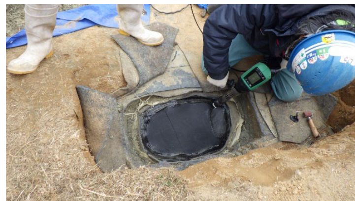
遮水シートの補修作業の様子（2月12日）
