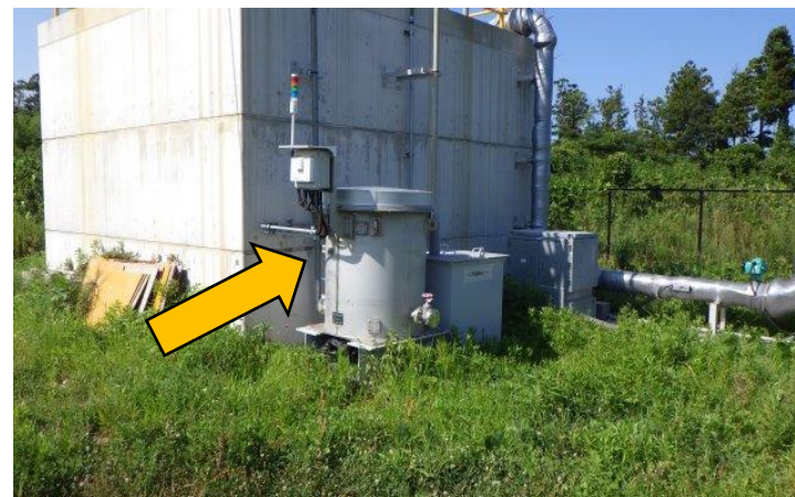
地下水（K2区画）測定用
