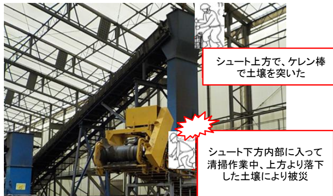
図 事故の発生状況
