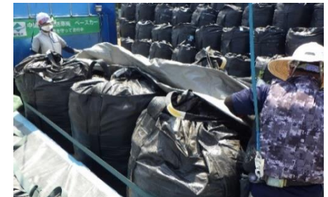
飛散・流出防止策（固縛）
