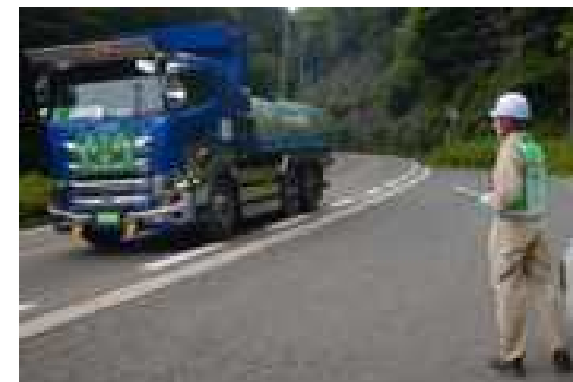
走行状況のパトロール
