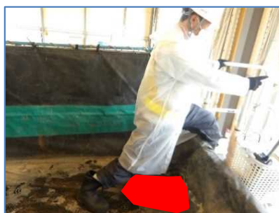
土のうを跨いで足を置いた
