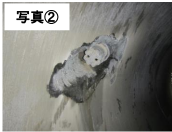
【ヒューム管内面貫通部】
