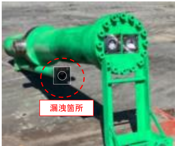
【作動油が漏洩した圧縮梱包機】
