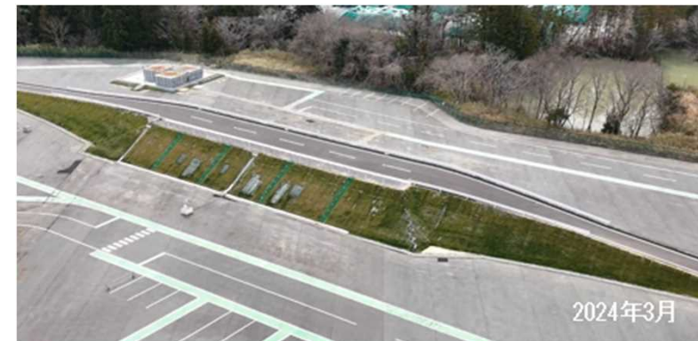
◇中間貯蔵施設内（大熊町）での道路盛土実証事業
