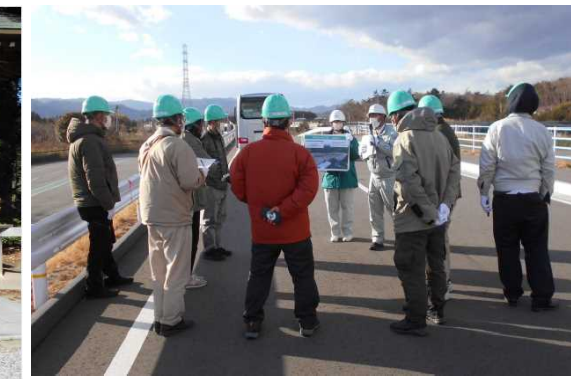
大熊工区 道路盛土実証
