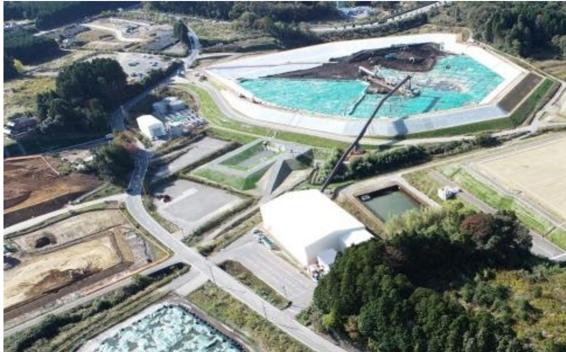
土壌貯蔵施設(西側)
