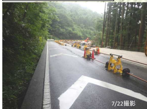
①工区伐採完了
