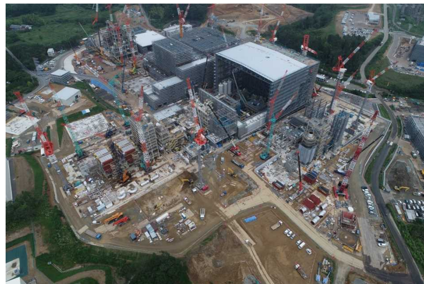
ヤード全景：7月19日現在
