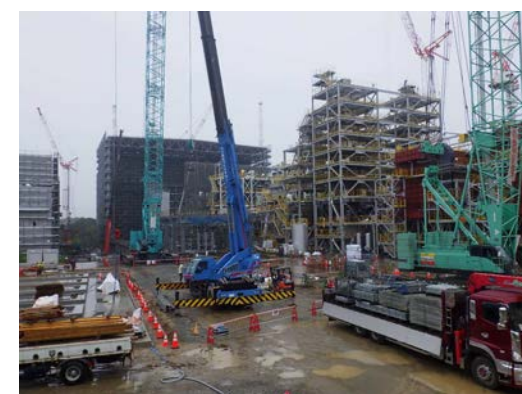
仮設灰処理施設：機器据付
