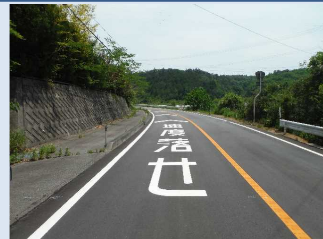
改良工事後の道路の様子(国道288号)
