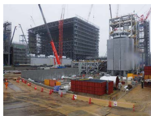
仮設焼却施設：機器据付
