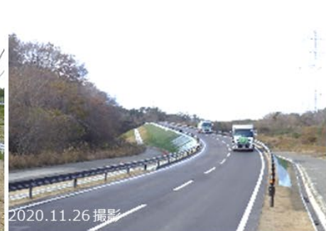
④工事用道路の整備（完了）
