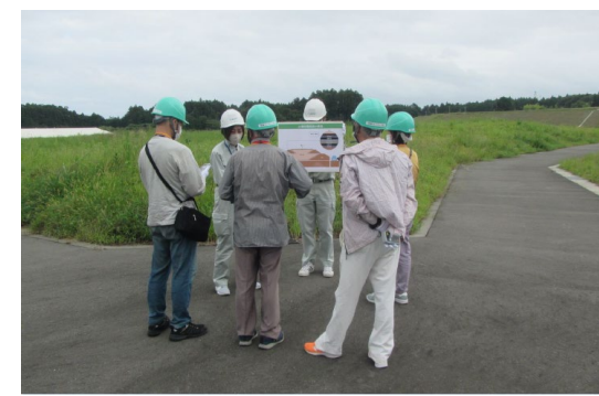
双葉工区 土壌貯蔵施設
