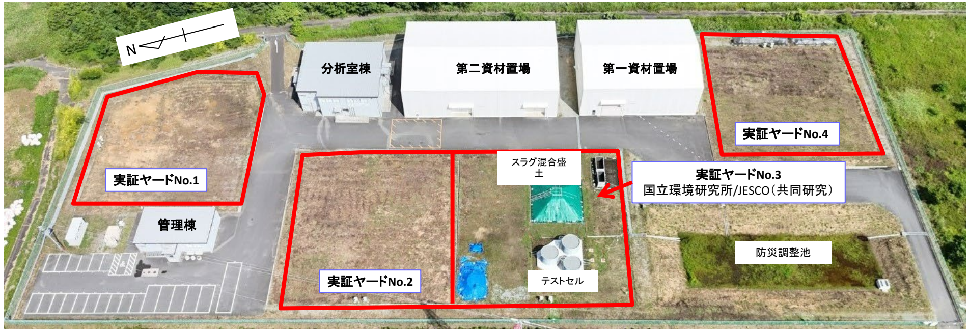
ドローンによる技術実証フィールド全景(2025年8月2日時点)
