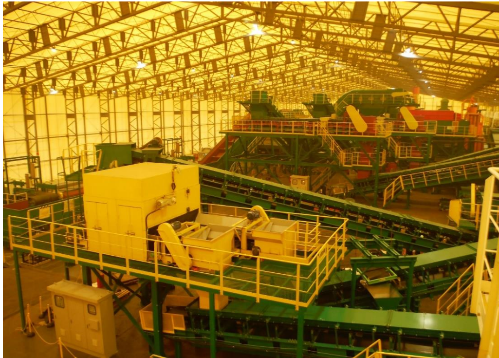
受入・分別施設(受入・分別棟内部)
