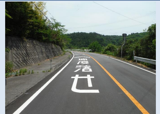
改良工事後の道路の様子(国道288号線)
