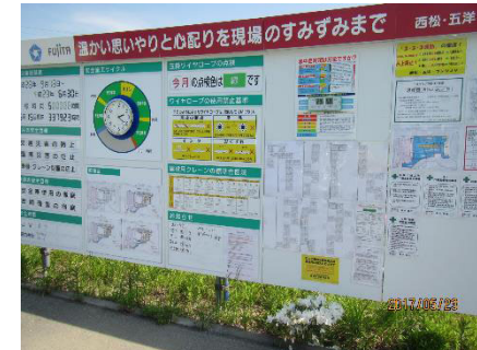
施工体制他安全表示確認
