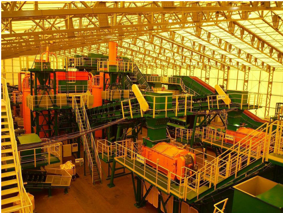
受入・分別施設の建屋内部
