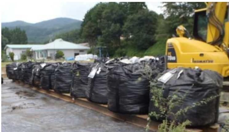
図 2.1.3-6 水切り架台の設置状況の例
