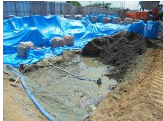
図 2.1.3-4 発生する濁水や浸出水等の回収と処理
