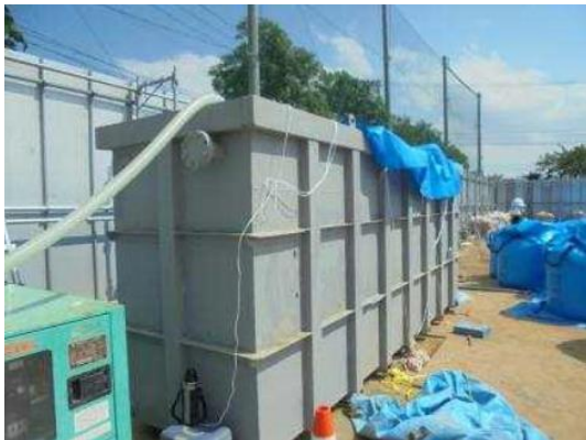
図 2.1.3-4 発生する濁水や浸出水等の回収と処理
