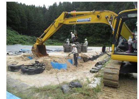
直接覆土の除去作業
