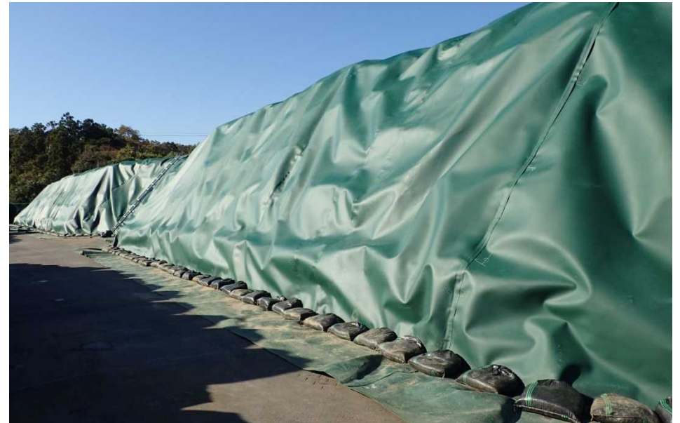
搬入完了後(一山完成後)における 遮水シートの状況
