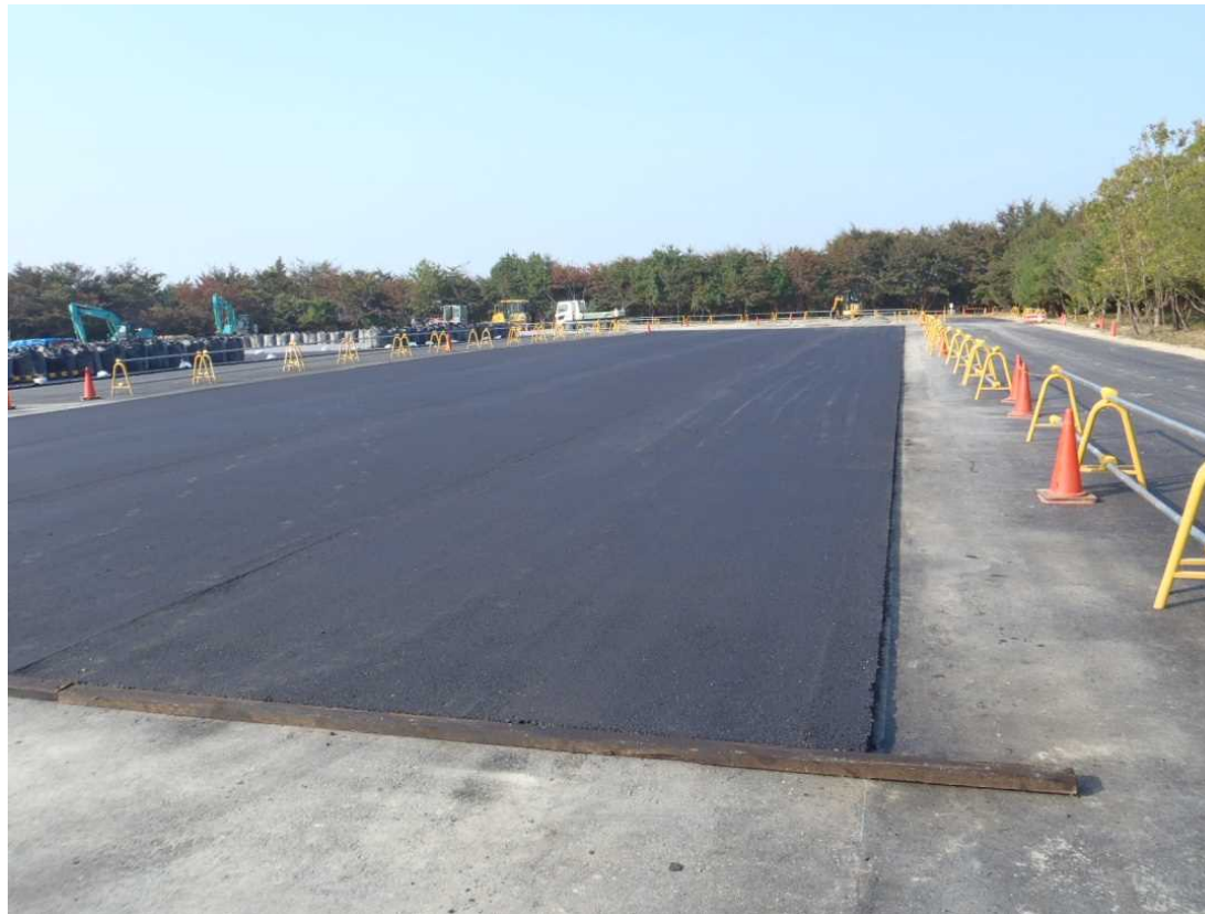
保管場の舗装状況の例
