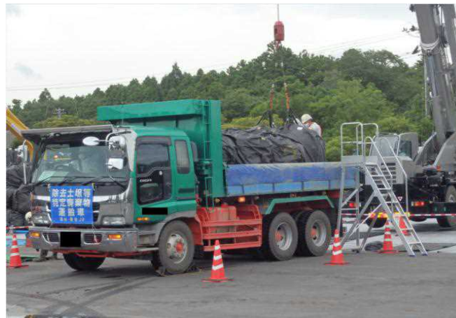
保管場作業の状況確認
