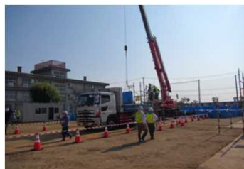
積込機材（クレーン）
