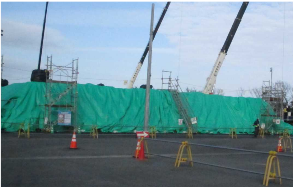
搬入中における遮水シートの状況
