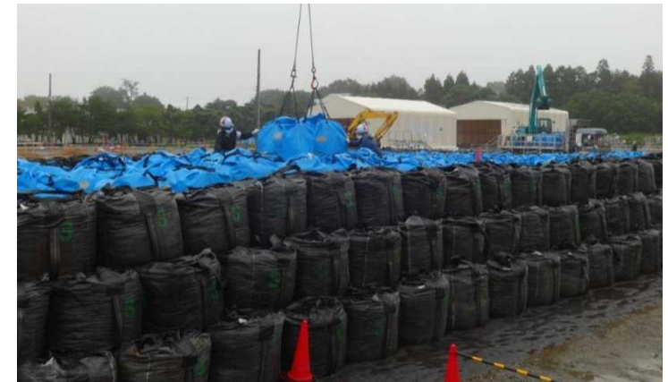
保管場への定置作業
