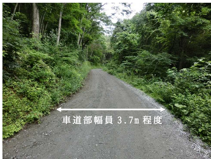
図 7-2 仮置場へのアクセス道路の状況（例）
