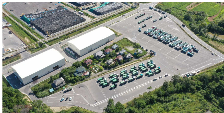
東大和久車両待機場の活用状況
