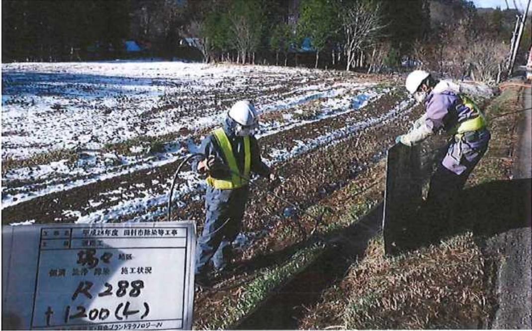
写真 側溝の高圧洗浄実施状況（後方にバキュームあり）
