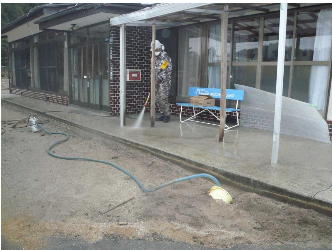
写真 12月17日 指摘された個人宅における高圧洗浄の様子（ポンプピットが設置されている）
