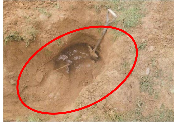
②掘削して小型土のうを発見
