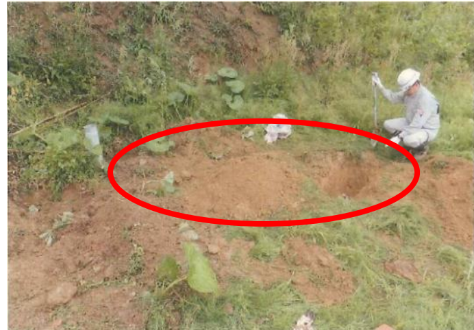
④掘削後除去土壌を掘り出した後の状態
