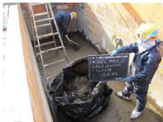
沈殿固化物の回収
