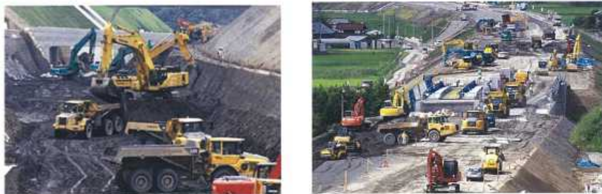
図参-9 工事状況写真
